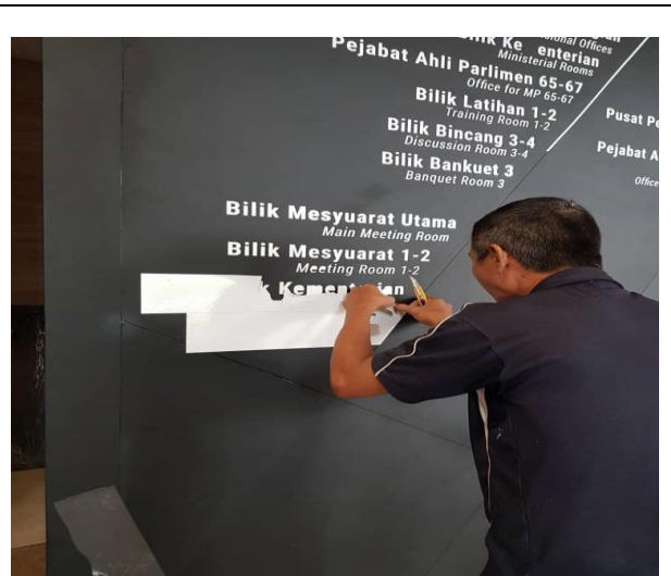
Aras Tanah – Pemasangan Signage
