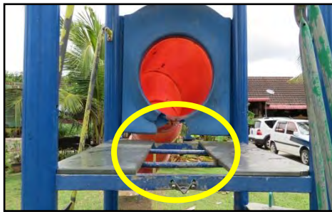
Taman Desarena, Alor Setar - Kerosakan pada Integrated Playground (05.04.2017)
