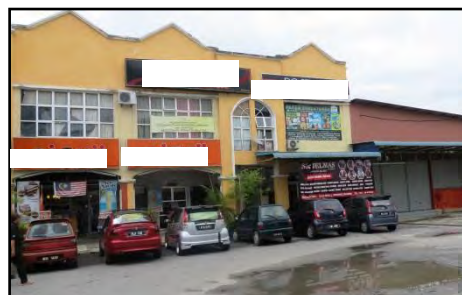
No.11, Bangunan MAIK, Jalan Liku, Baling - Bangunan Rumah Kedai Yang Mempunyai Tunggakan Tinggi (09.05.2017)
