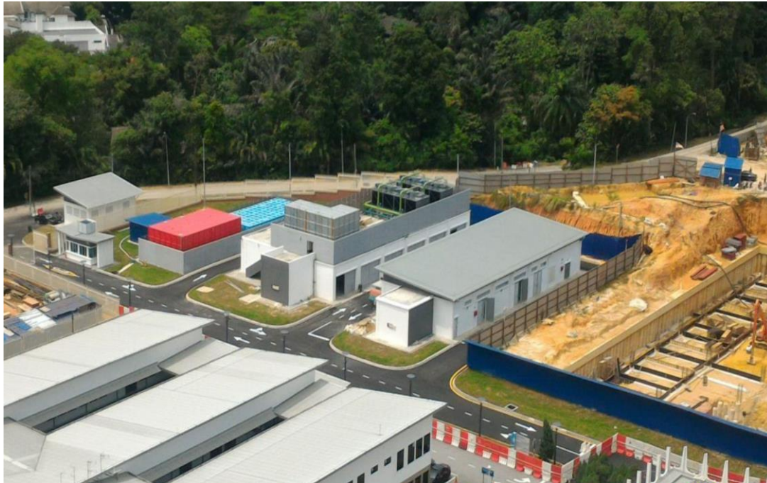
BLOK MEKANIKAL DAN ELEKTRIK
