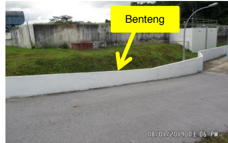
APK No. 4: Tambahan Benteng dan Kerja Mekanikal dan Elektrikal ke Stesen Pam Air Terawat dan Stesen Pam Air Mentah (08.01.2019) (Sumber: Jabatan Audit Negara)
