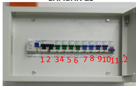
Bilik Papan Suis Utama, Bilik Pengubah dan Bilik Switchgear - Lukisan Siap Bina Sama Sepertimana Pemasangan Litar Akhir Dalam Kotak Agihan di Tapak (24.04.2019) (Sumber: Dewan Bandaraya Kuching Utara)
