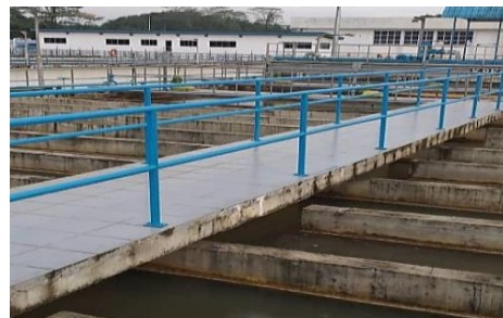
LRA Batu Kitang No. 3 - Pemegang Susur Tangan Berjenis Keluli Lembut Telah Dipasang di Laluan Jalan Kaki LRA (28.08.2019) (Sumber: Jabatan Audit Negara)
