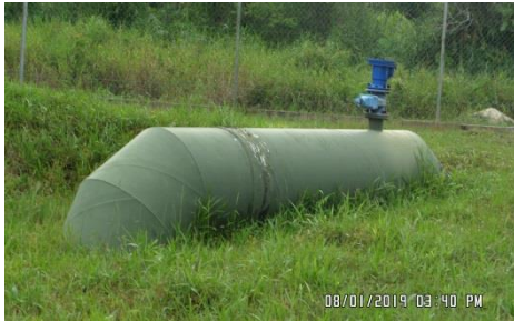
APK No. 3: MSCL Paip bergaris pusat 1000mm daripada Loji 3 ke Zon Perindustrian Bebas Samajaya (08.01.2019) (Sumber: Jabatan Audit Negara)
