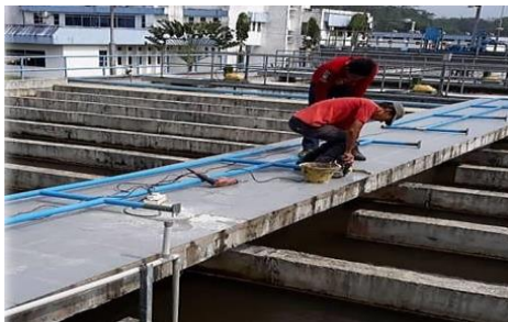
LRA Batu Kitang No. 3 - Kerja Pemasangan Pemegang Susur Tangan Berjenis Keluli Lembut di Laluan Jalan Kaki LRA Sedang Dijalankan (23.08.2019) (Sumber: Jabatan Audit Negara)
