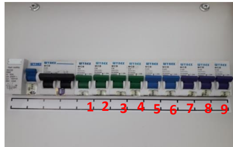
Bilik Papan Suis Utama, Bilik Pengubah dan Bilik Switchgear - Lukisan Siap Bina Tidak Sepertimana Pemasangan Litar Akhir Dalam Kotak Agihan di Tapak (16.01.2019) (Sumber: Jabatan Audit Negara)
