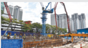
Kawasan binaan Construction area
